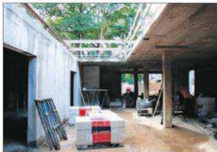
Opengewerkt dak. foto Peter Zandee
